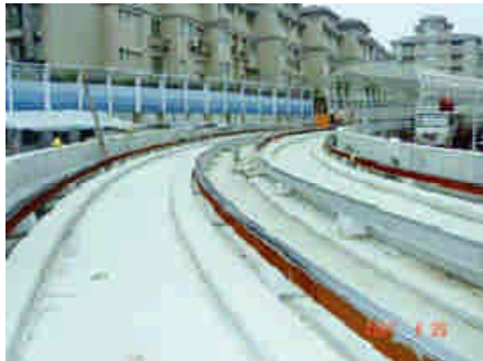
圖 4 鋼筋混凝土路面
