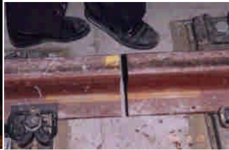
圖 15 鋁熱焊接法
